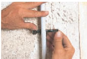
**18. Scier le tube avec une scie à denture fine.**
