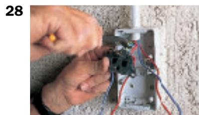
26. Enfiler l'extrémité du tube — et les fils qu'il conduit — dans le boîtier de prise sur 1 cm.
